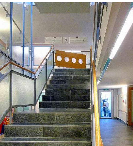
Escalier intérieur avec luminaires linéaires adjacents.
