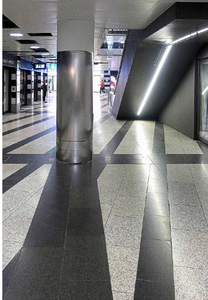
Gare centrale de Zurich: les rayures sombres sur le sol sans fonction d'orientation, ainsi que la matière brillante des colonnes et l'éclairage linéaire sous l'escalier mécanique, dirigent les personnes malvoyantes vers des zones dangereuses.
